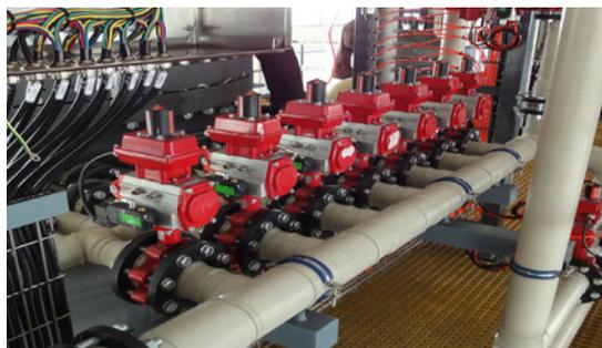
Рис. 3: Выпускные отверстия для фильтрата, включая смотровое стекло для каждого выпускного отверстия. Выпускные отверстия сгруппированы в коллекторы с отдельными клапанами с пневматическим приводом, ведущими в коллектор фильтрата.
